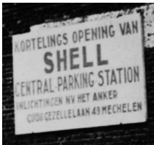
(detail uit de foto links onder)
