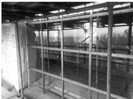
Restauratie van de steunberen
