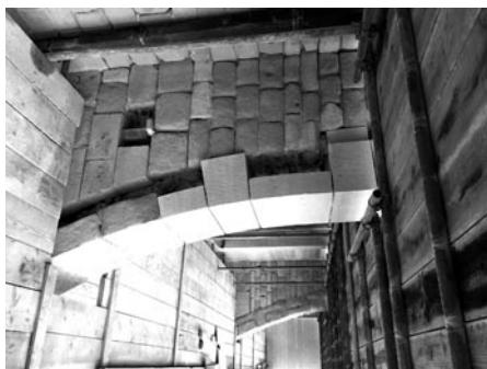
Restauratie van de steunberen
